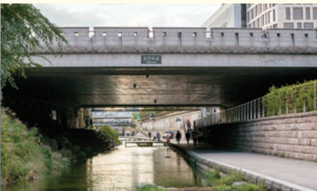
* 现在的清溪川五间水桥
